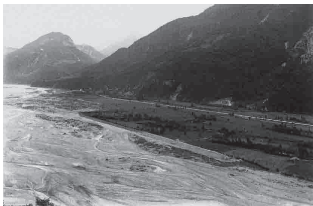
Fig. 3 - La piana a nord di Tolmezzo in sinistra But nell'anno 1933. La foto è stata scattata durante i lavori di prolungamento dell'antica rosta "del Sette" .
