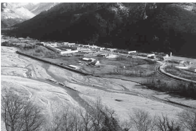
Fig. 4 - La piana a nord di Tolmezzo in sinistra But nell'anno 2000, occupata dagli insediamenti industriali, commerciali e dalle superstiti aziende agricole; in alto si staglia la vasta costruzione del nuovo penitenziario.
