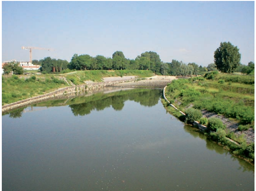
Fiume Brenta: sistema di dissipazione dell'energia dell'acqua a valle di uno sbarramento che precede un ponte entro un alveo canalizzato
