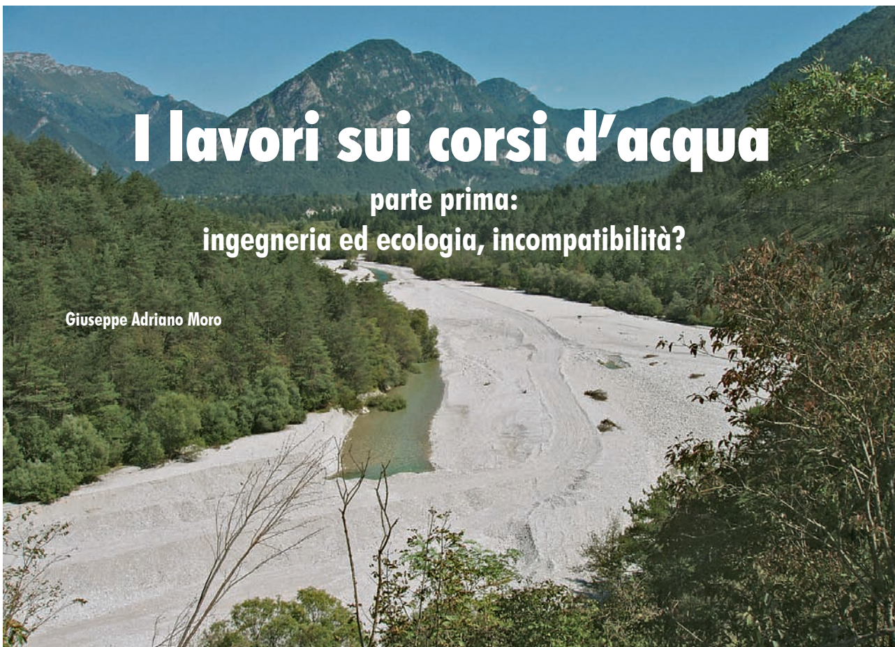
Torrente Meduna: lavori di ricalibrazione mediante asportazione di inerti dall'alveo
