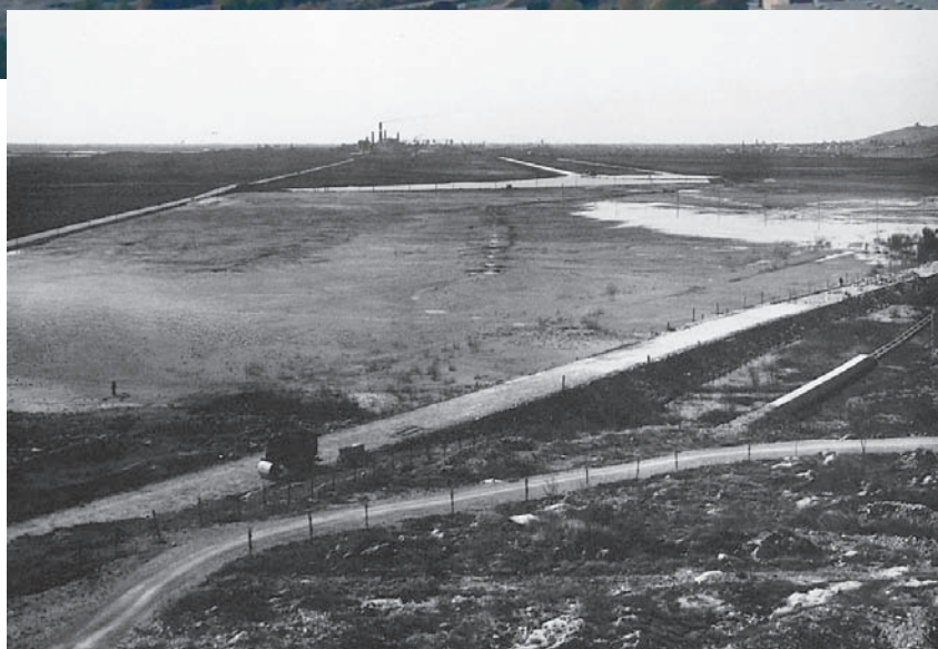
Il Lisert nel 1933. In primo piano i lavori di costruzione della nuova Statale 14, poi la palude della Risaia, dove sorgerà la Cartiera. Sullo sfondo lo stabilimento Adria-Solvay e il tracciato della vecchia strada con il ponte sul Locavaz poi demolito.
