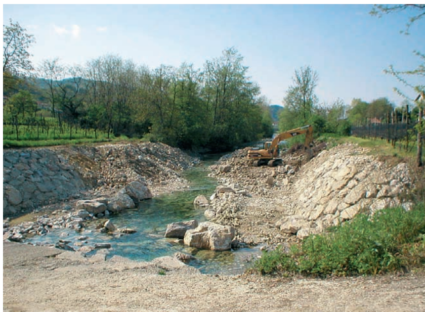
Torrente Cornappo: creazione di protezioni spondali in un torrente pedemontano. Sullo sfondo si osserva l'aspetto originario delle sponde
