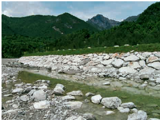
Esempio di sistemazione spondale con massi ciclopici non fuggiti ma senza alcun impianto di arbusti
