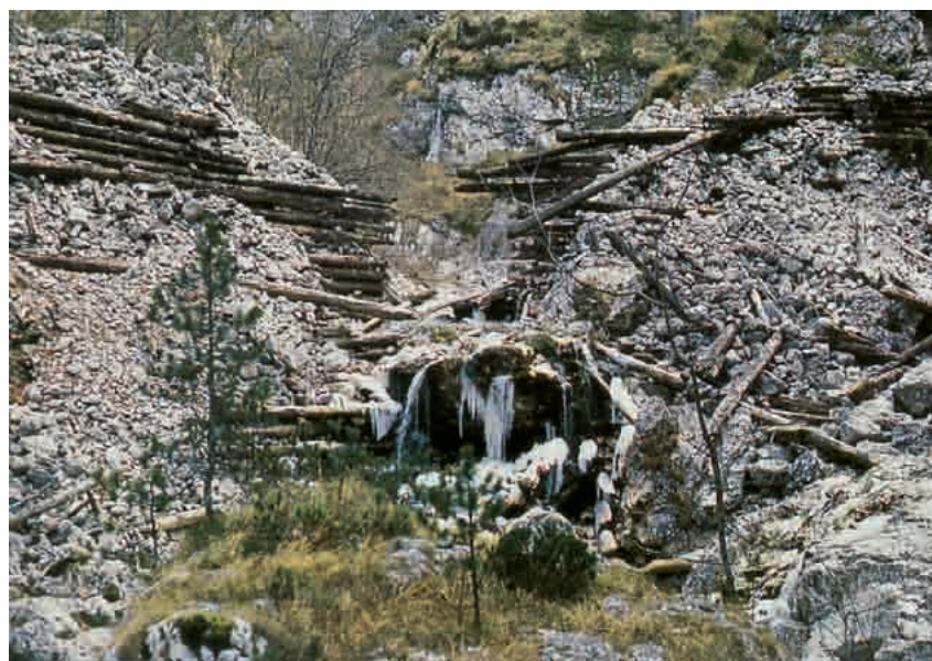
I resti imponenti della chiusa superiore del Rio Tralba (Moggio Udinese)
