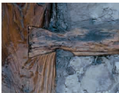
Tipico incastro ligneo tra gli elementi della parete di monte e le incastellature retrostanti, nella chiusa del Rio Variola (Tolmezzo).
