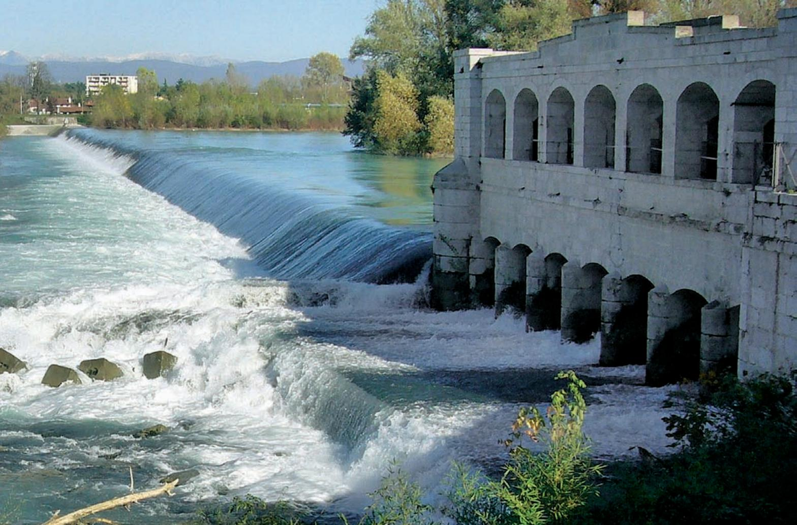
*Opere di presa del canale Dottori sull'Isonzo a Sagrado. In evidenza la briglia sommergibile che taglia il fiume e, a destra, lo sghiaiatore.*
