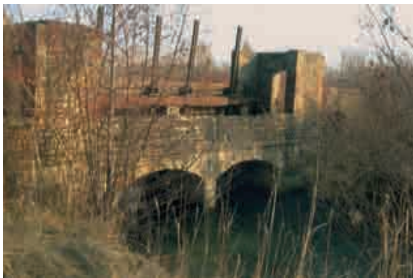
Ponte sul canale Amman
