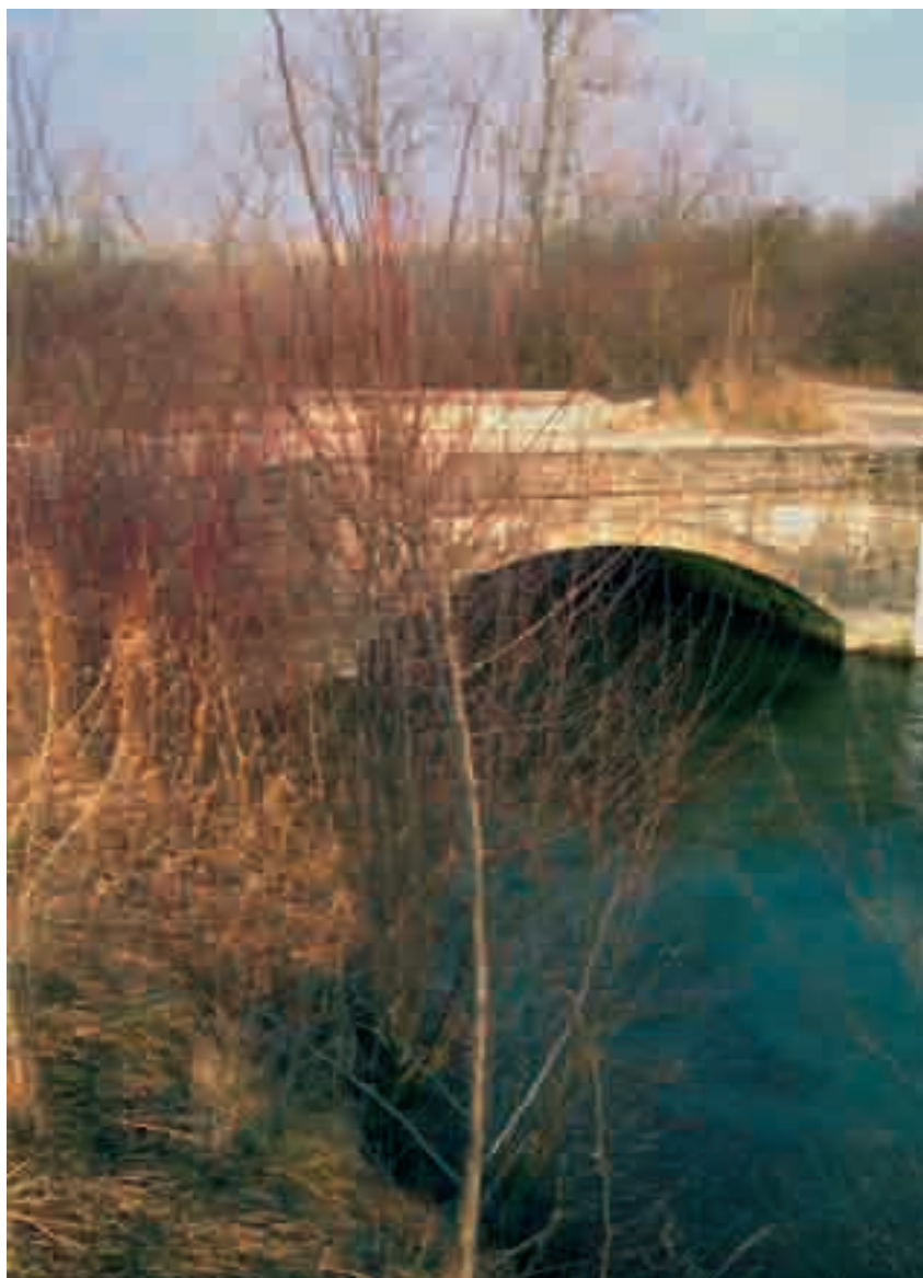
Cordenons. Ponte con paratoia sul canale Amman
