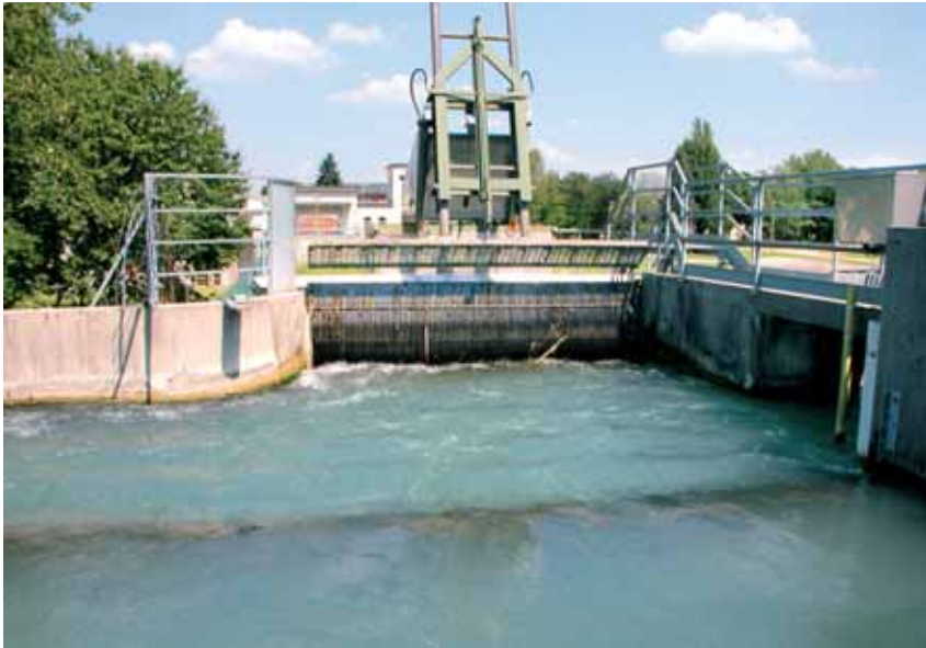
Paratie per la regolazione delle acque (zona ex Cotonificio Udinese)
