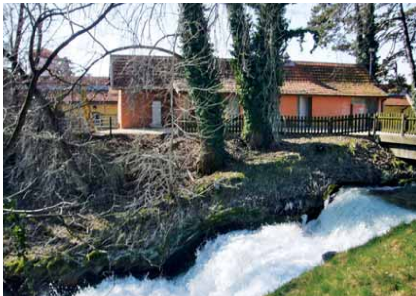
Cascatelle per la produzione di forza motrice nell'insediamento industriale ora Fiera di Udine
