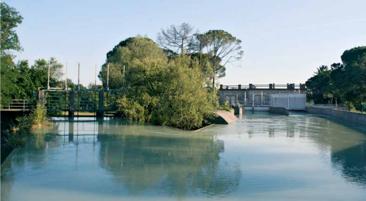
Centralina idroelettrica (Rive D'Arcano)
