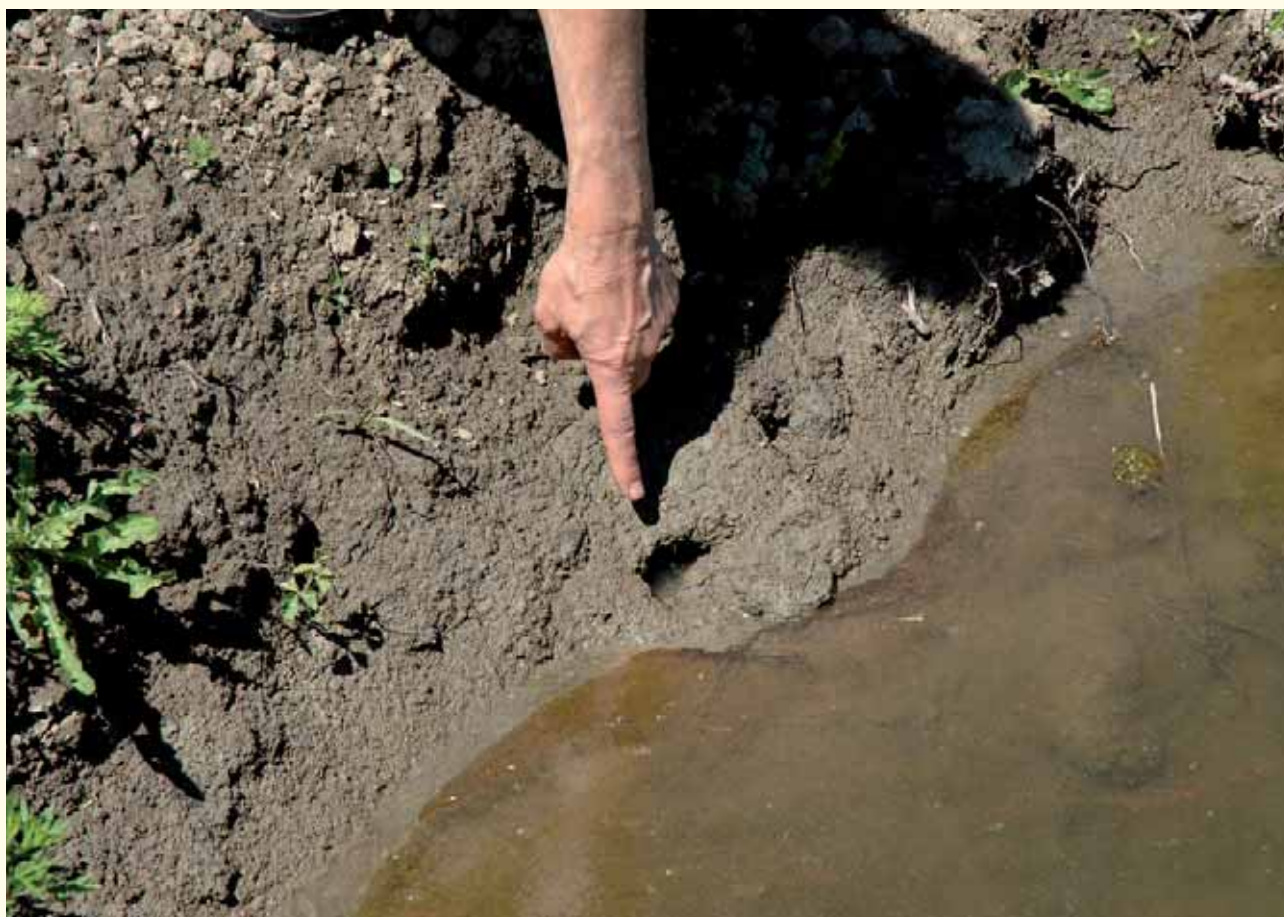
Il gambero rosso della Louisiana ( Procambarus clarkii ) scava tane profonde, i cui fori di ingresso risultano spesso ben visibili lungo le sponde degli argini. Le tane rendono i terreni porosi, producono infiltrazioni d'acqua, con frequenti cedimenti strutturali e crolli.
