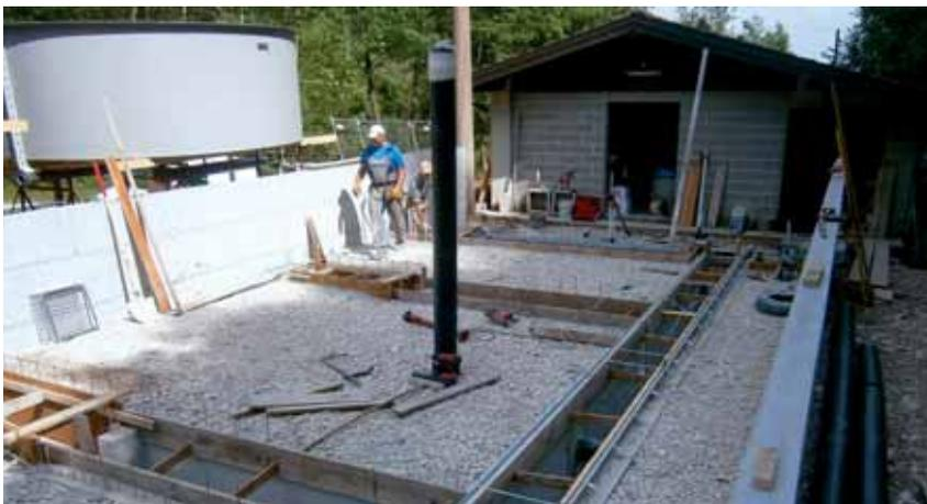
*Fasi di lavorazione per la realizzazione della pavimentazione di appoggio delle vasche*
