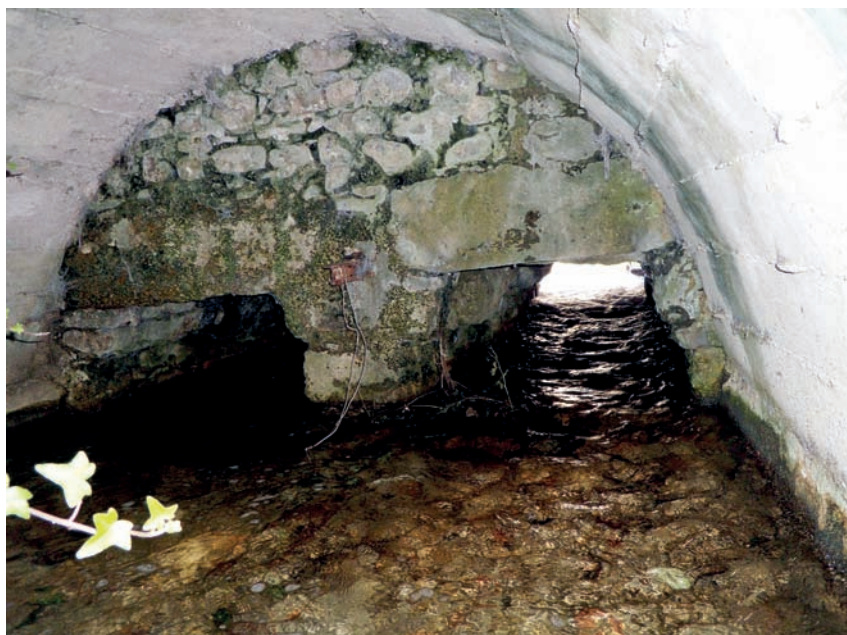
La Roggia di Spilimbergo in corrispondenza del ponte SP di Lestans.
