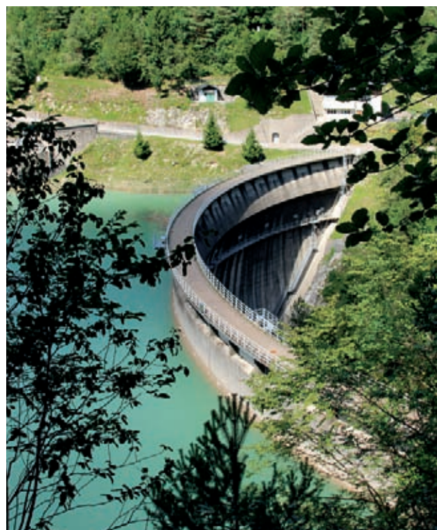
Lo sbarramento di Verzegnis.
