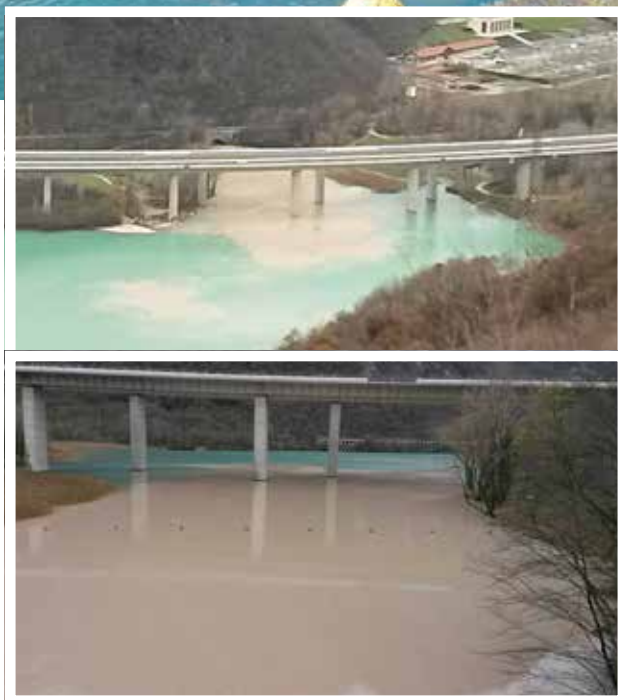
Scarico della centrale di Somplago, 28/11/2014 (foto Stazione forestale di Tolmezzo - Isp. Paolo Machin).
