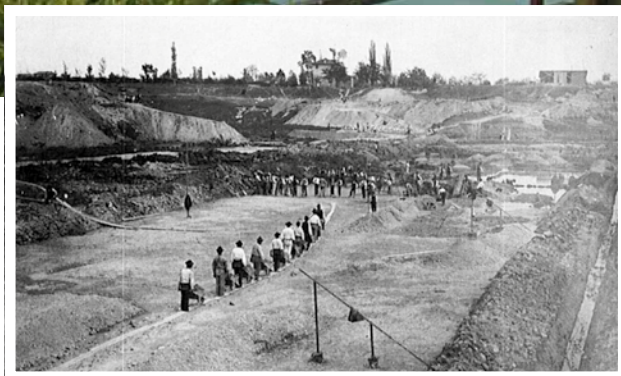
Foto d'epoca dei lavori di scavo.
